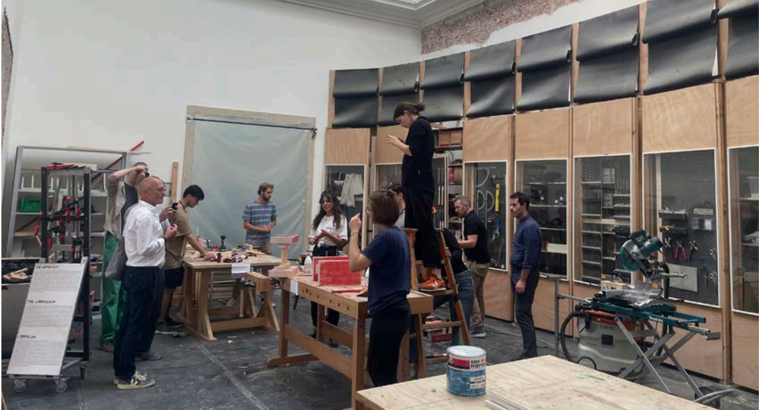
German Pavilion - Open for Maintenance/Wegen Umbau geöffnet
