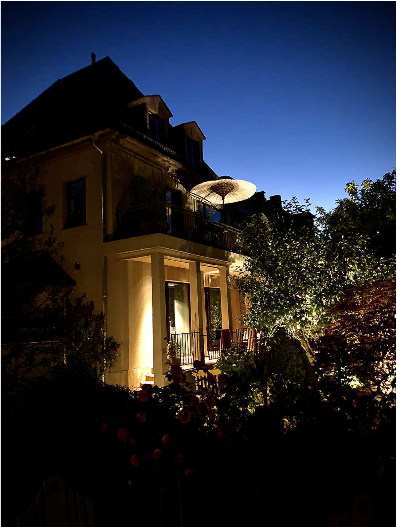
Entwurf: Jan Leithäuser, www.janleithaeuser.de Bauherr: Dipl. Ing. AKH & BDIA Innenarchitekt Jan Leithäuser Standort: Niemandsfeld 12, 60435 Frankfurt Fertigstellung: August 2018 Fotograf: Jan Leithäuser
