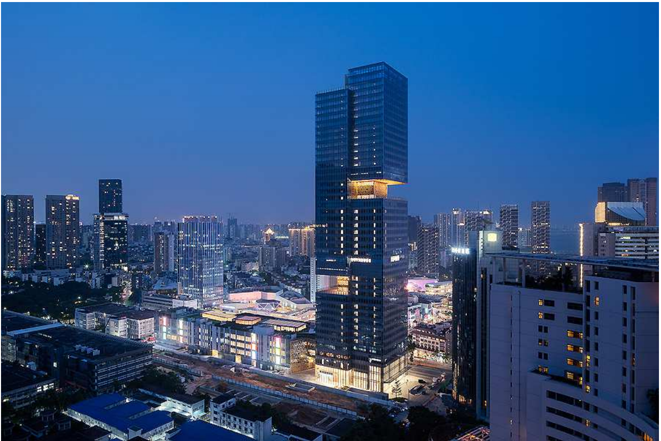
Entwurf: OMA, www.oma.eu Bauherr: CMSK (China Merchants Shekou Holdings) Standort: Shenzhen, China Fertigstellung: 2020 Fotos: Seth Powers for OMA
